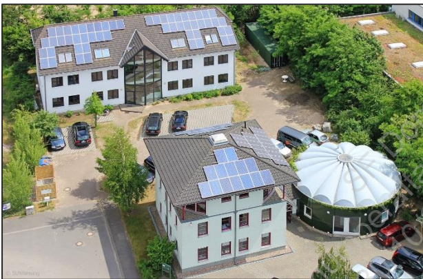
Nuestra matriz en Erkner/ Berlin, Alemania. Está equipada con 2 plantas FV: 26.8 kW p y 8.06 kW p
